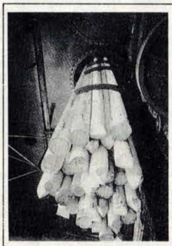
Oszlopok telítése a Püspökladányi Üzemből
