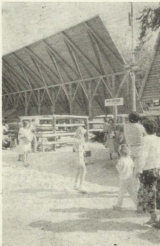
4. ábra. Makovecz-féle tetőszerkezet
