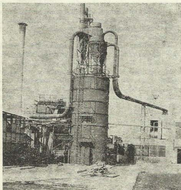
2. ábra. Energiaüzem (CCT)
