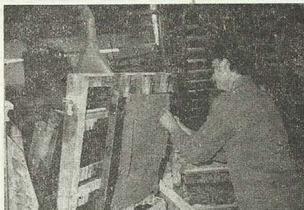
22. ábra. Az öntőformába a párnázatot erősítő betétek elhelyezése
