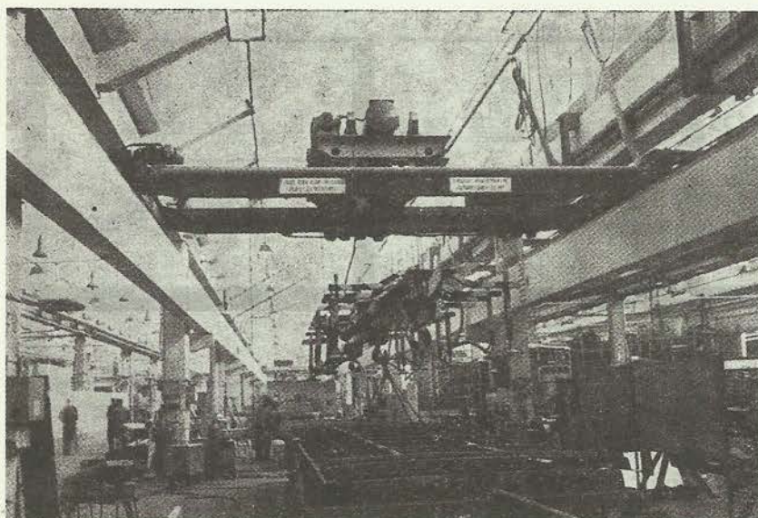
4. ábra. Markolós futódaru rögzített függőkapcsolóval
