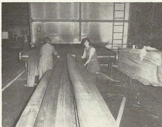
5. ábra. Az akác furnér szárítása
