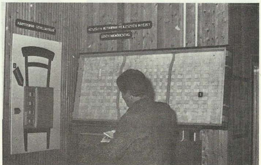
3. ábra. Az OKE cég műanyag hevederének elkészített szék és heverő tartólap
