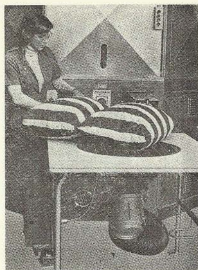
18. ábra. Párnatöltés a MODAN típusú aprítéktöltő gépen
