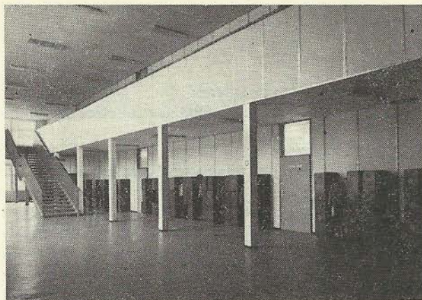
A Székesfehérvári ÁÉV által kifejlesztett CLASP építőipari rendszerű iskola, CK-lap belső burkolattal
