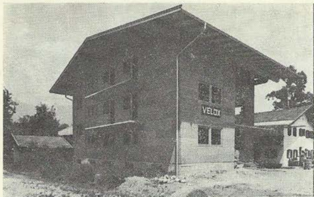
6. ábra: VELOX építőlapból készült társasház befejezés előtt
