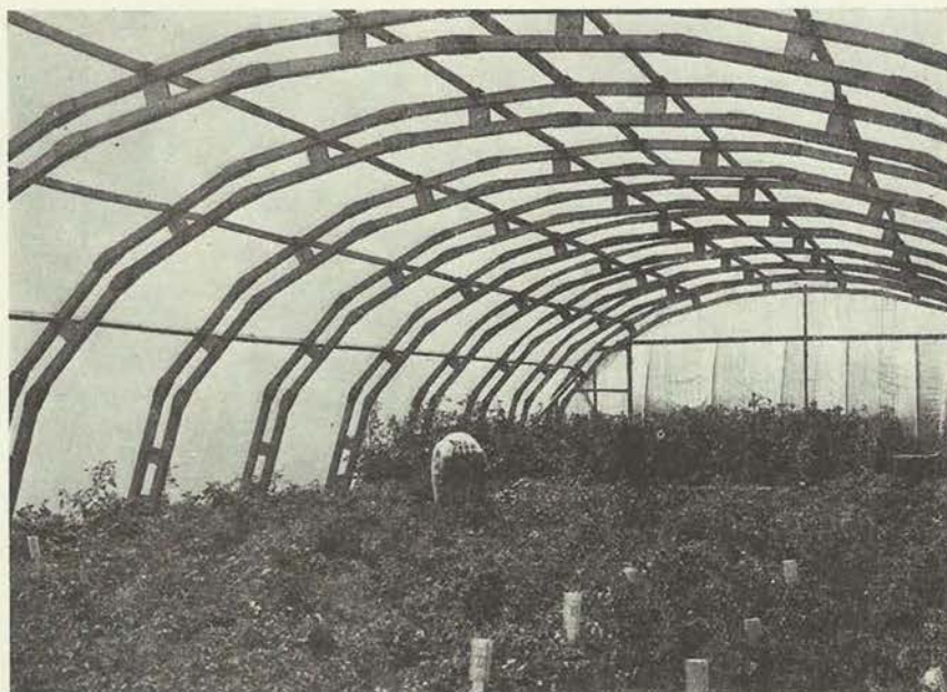
4. ábra. Szegezett-ragasztott kivitelű fóliaház
