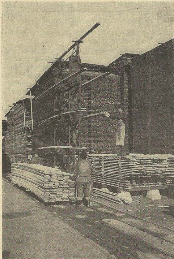
2. ábra. Fűrészáru máglyázás kettős vágányhálózatról, pályakocsiról, máglyázó géppel
