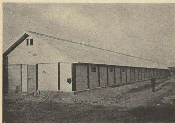
9. ábra. Mezőgazdasági állattartó épület (sertésfiasztató) fűrészek (szombathelyi) által építve, saját gyártású fa-épület szerkezettel
