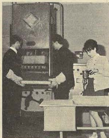
6. ábra. Forgácslap előállítása laboratóriumi présen hallgatói gyakorlat keretében
