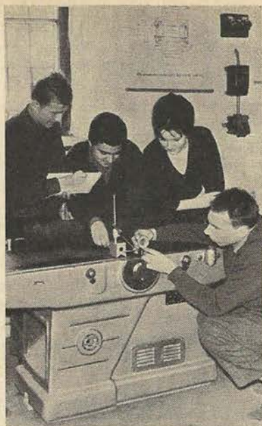
8. ábra. A Faipari Géptani Tanszéken a hallgatók gyakorlati oktatás keretében az egyengető gyalugép pontosságát vizsgálják
