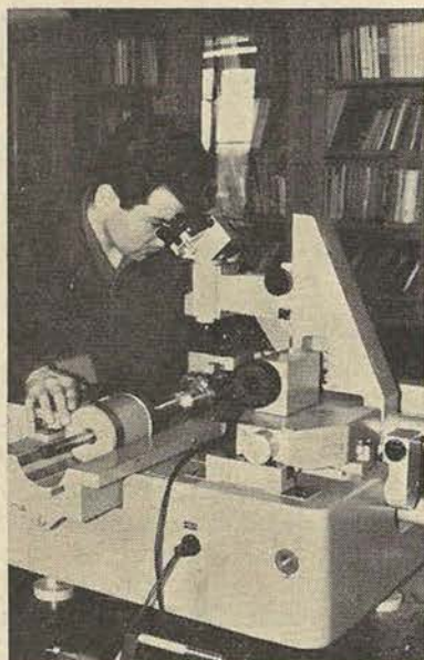
4. ábra. Zeiss-féle műhelymikroszkóp használata, számszámok bevizsgálása, hallgatói gyakorlat keretében
