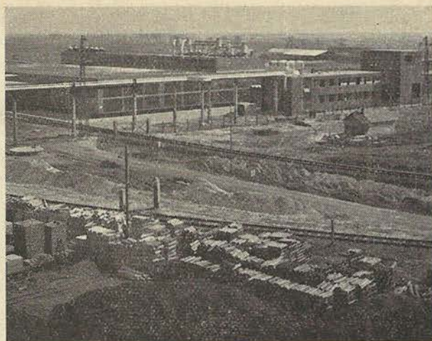
5. ábra. A II. sz. faforgácslapgyár (előlnézetben)
