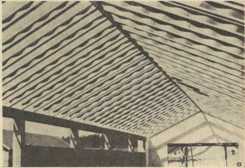
2. ábra. Fedélszerkezet „Wellsteg” tartókból
