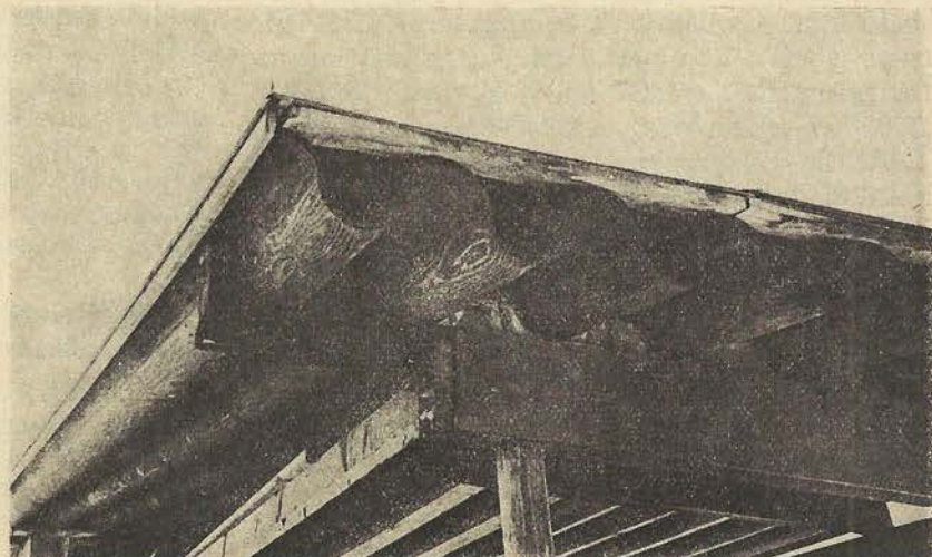
7. ábra. „Ruho” elemek alkalmazása épületfedésként jellegzetes párkányrajzot ad
