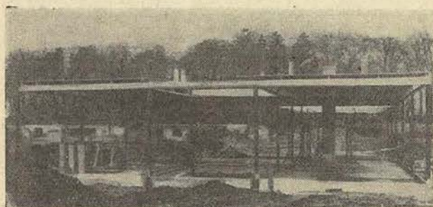
5. ábra. Acélvázás lakóépület födém szerelése, a faelemek elhelyezése előtt
