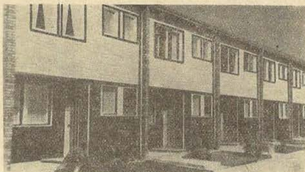
7. ábra. Előregyártott elemekből épült emeletes házak Finnországban
