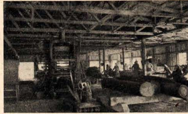
19. ábra. Az újjáépített vinyesándormajori fűrészcsarnok belső képe
