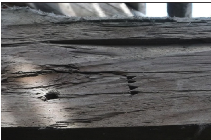
Igényes szerkezeti jelölés egy nagykanizsai barokk fedélszéken (Müller I.)
