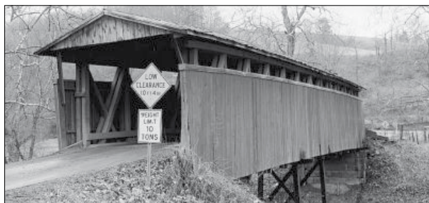
20. ábra Staats Mill híd Long-féle tartószerkezettel (Fotó: West Virginia, Division of Transportation, circa 1982)
