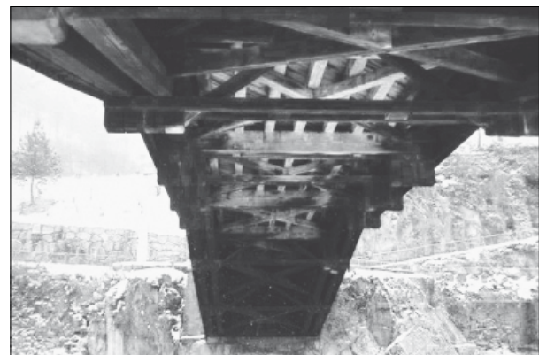
18. ábra A Murg hídjának háromszegmensű tartószerkezete (Forrás/Source: Philip Caston, 2009)
