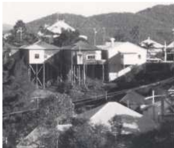
9. ábra – Magas cölöpalapok Brisbane meredek lejtőin
