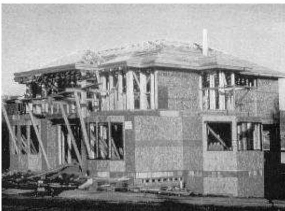
4. ábra – Félkész lakóház OSB felhasználásával
