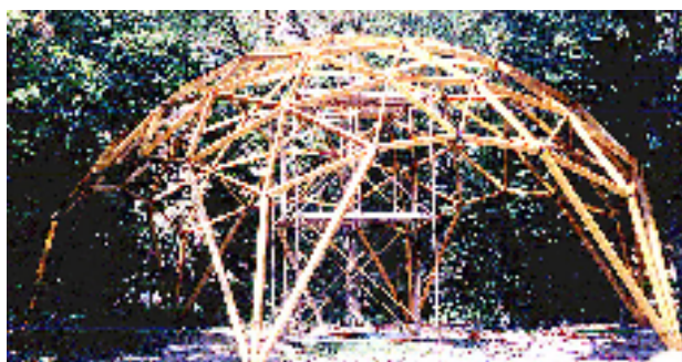
3. ábra - A háromszög rácsszerkezet burkolás előtt.
