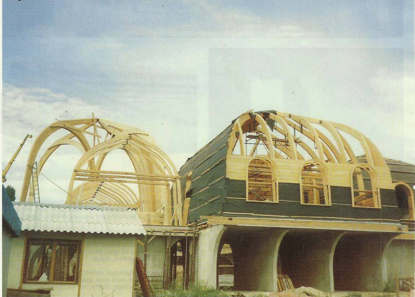
Ragasztott akácfából készített tetőszerkezet családi házon
