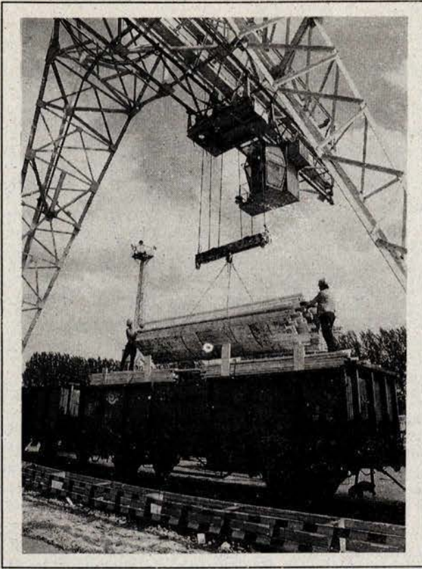
Fűrészáru-rakodás KKSZ-10. típusú bakdaruval
