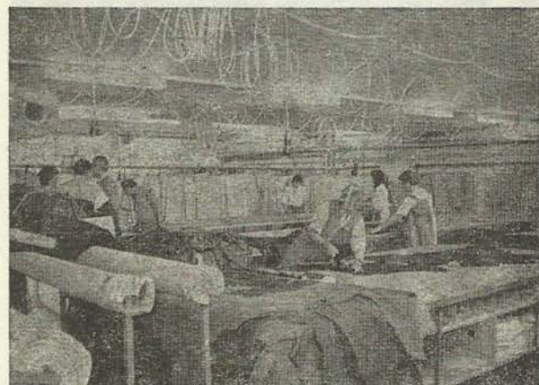
48. ábra. Bútorbőr szabása körkéses szabásgéppel. A szabászasztalok végénél a szövet és bőr tárolására készített állványok láthatók
