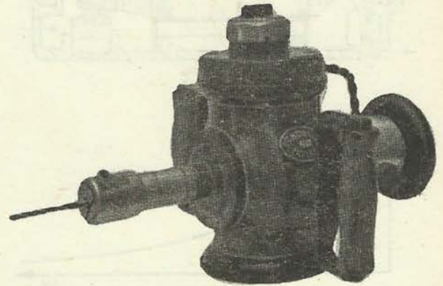
1. ábra. Az első villamos kézi fúrógép 1895-ből (a stuttgarti FEIN-gyár terméke)
