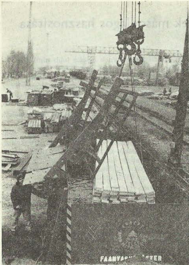
1. ábra. Fűrészáru berakása a védőszerrel feltöltött kádba
