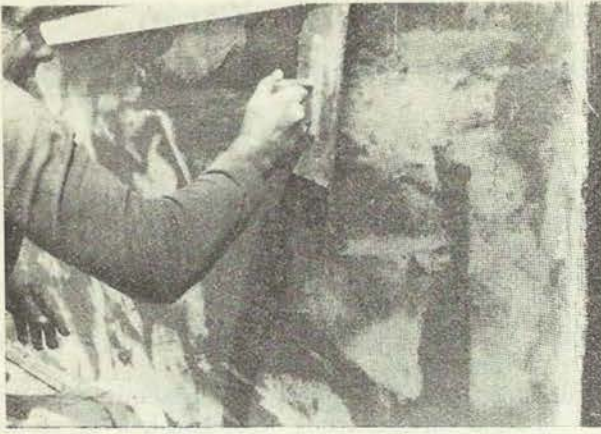
10. ábra. Üvegszálfonat felragasztása
