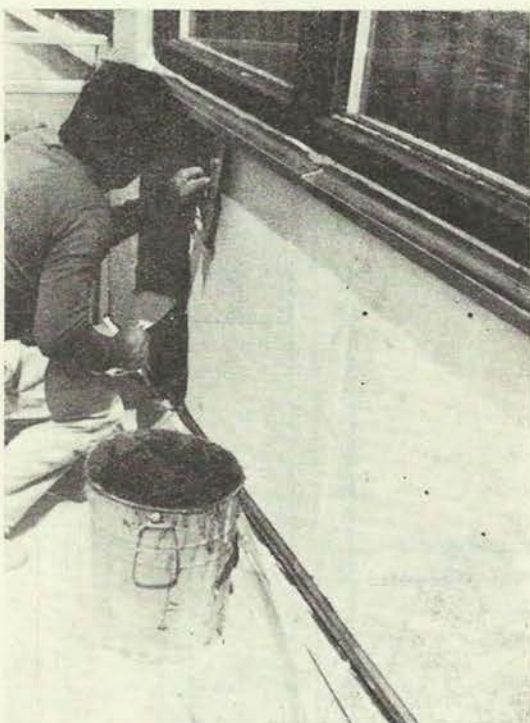
9. ábra. Primus alap felhordása
