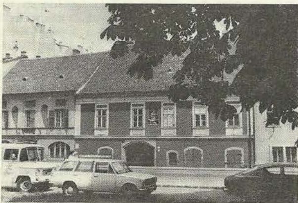
8. ábra. I. ker. Corvin tér 3. műemlék felújítás után
