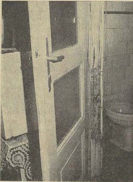
5. ábra. Teljes magasságig házigomba által roncsolt ajtószerkezet (Felvételt készítette Varga Margit)
