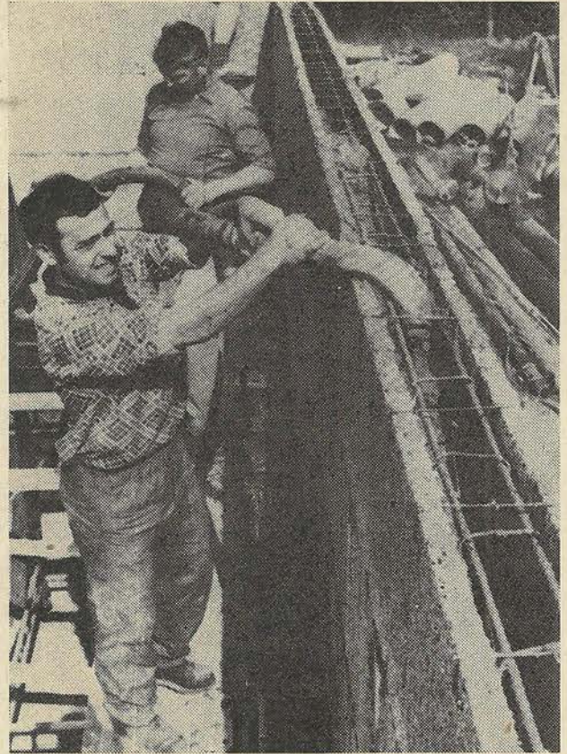
12. ábra: Bentmaradó zsaluzat töltése cementhabarccsal, szivattyú segítségével
