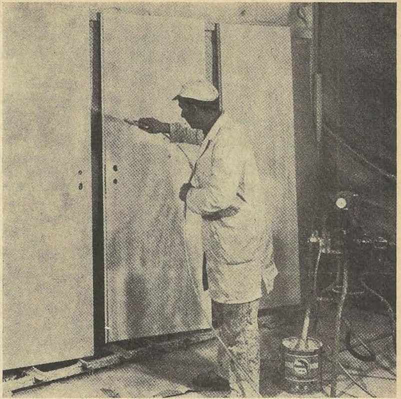
3. kép. Variant C—3020 R tip. fémállványra szerelt szóróberendezéssel ajtó felületek szórása. (Vajfehér színes anyaggal)
