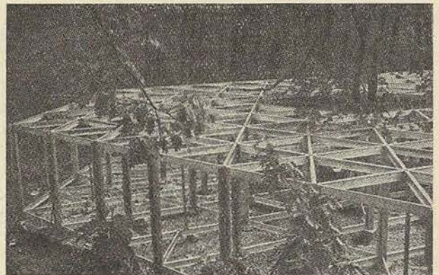
2. Trelement-rendszerű épület vázszerkezete
