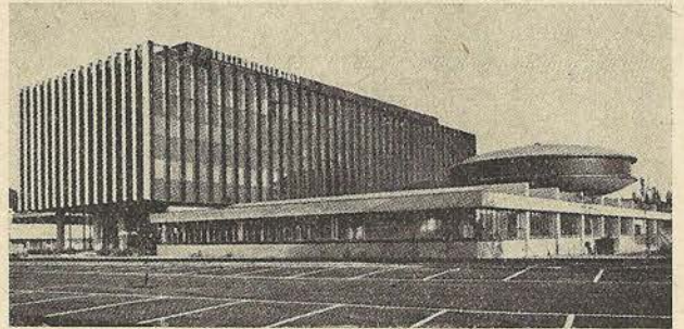
1. ábra. ETA Faipari Központ. Balra a főépület, jobbra a kiállítási csarnok, háttérben a Stúdió épülete helyezkedik el
