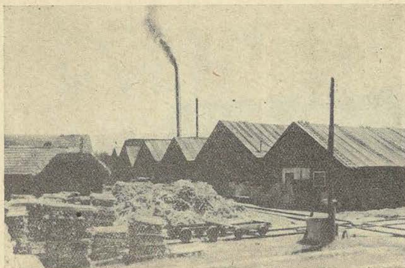
2. ábra. A barcsi fűrészüzem régi csarnoka a zsúfolt beépítésre és a célszerűtlen alaprajzú és szerkezeti felépítésű üzemi épületre mutat példát
