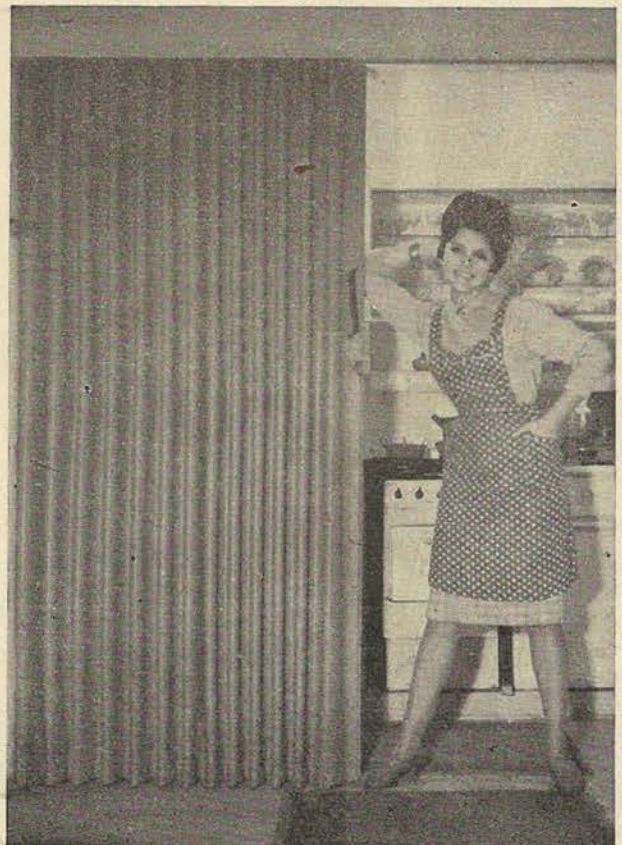
10. ábra. Harmonika rendszerű műbőrborítású ajtó, mely válaszfalnak is alkalmazható
