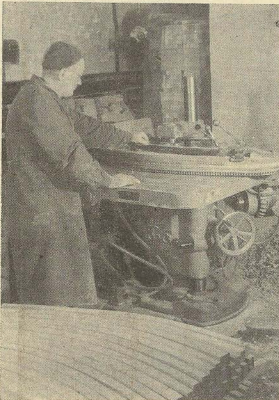
1. ábra. Hajlított hátsó széklábak kétoldali idommarása (egyben spiccelve) 2. oldali maró-sablonnal
