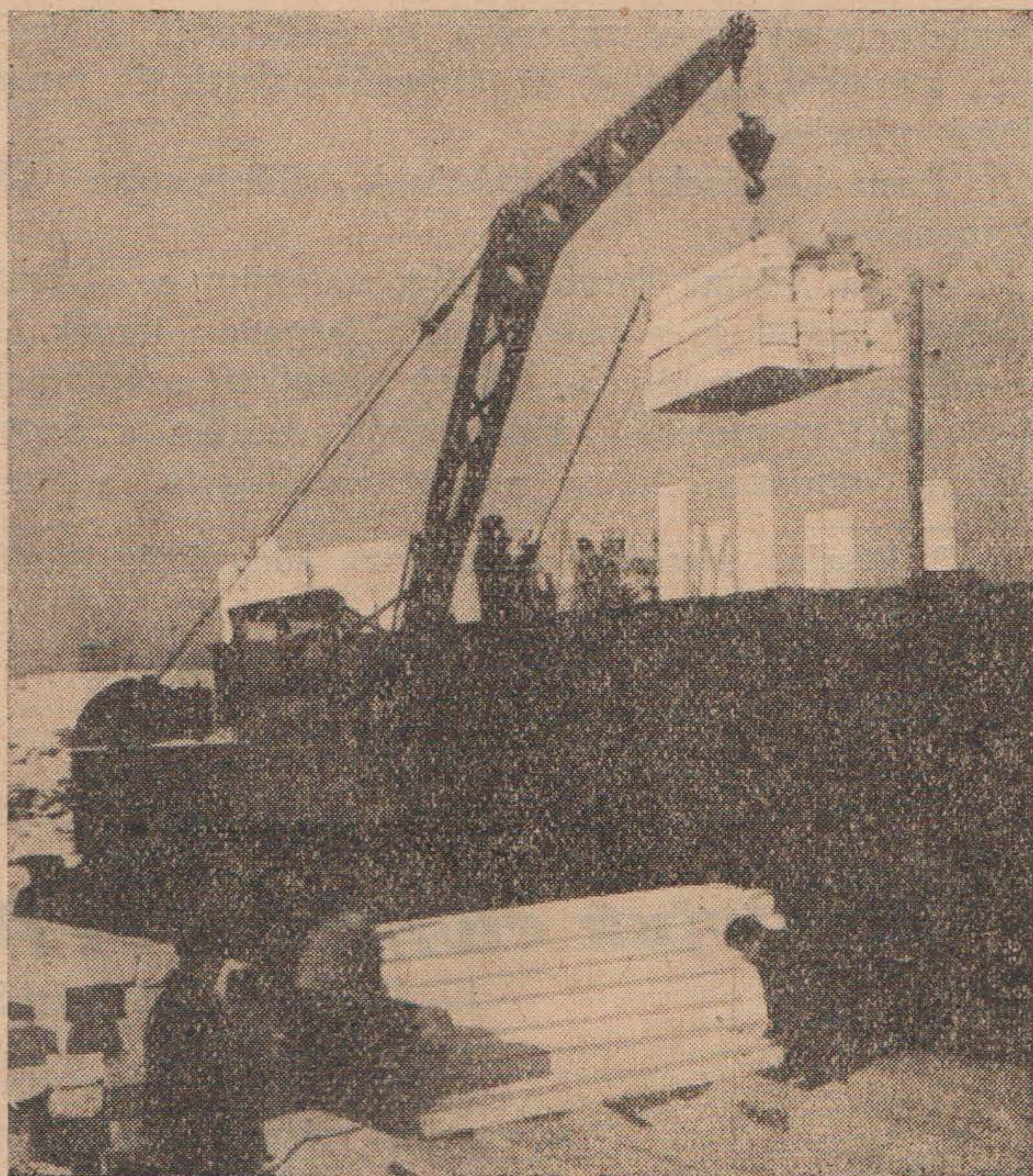
Talpfák vagonbarakása elektromos daruval Kama vidéken
