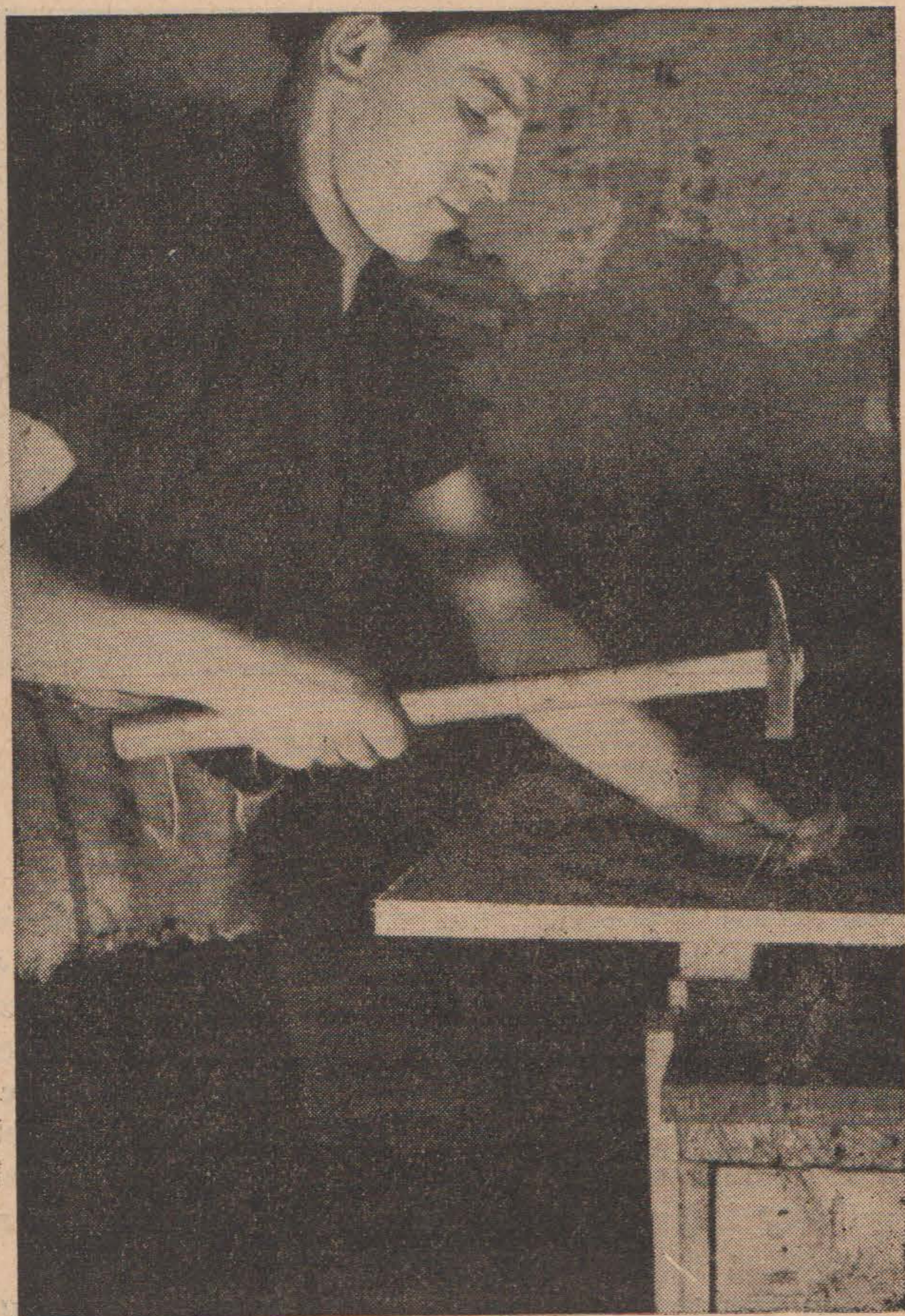
MEZEI JÓZSEF sztahanovista (Bpesti Ládagyár) szegezés közben. A fényképen jól látható 70°-os szögbeállítás
