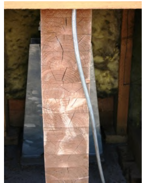
4. ábra A tapolcai rendezvénycsarnok repedt tartójának bütüje
