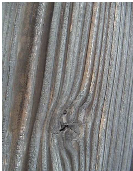
1. ábra – Egy japán templom időjárás viszontagságainak kitéve egyik tartóoszlopának fényképe (valószínűleg gyertyánszil)
