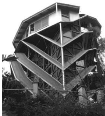
8. ábra – Az alsó három szint külső falaira kiülő, hullámlemez borítású negyedik szint
