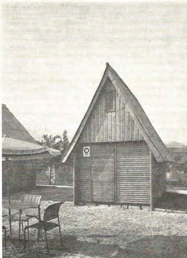
3. ábra. Import csehszlovák hétvégi ház. Típus: BA—22 Külső borítás: hasított félgömbfa Beépített alapterület: 16,30 m 2
