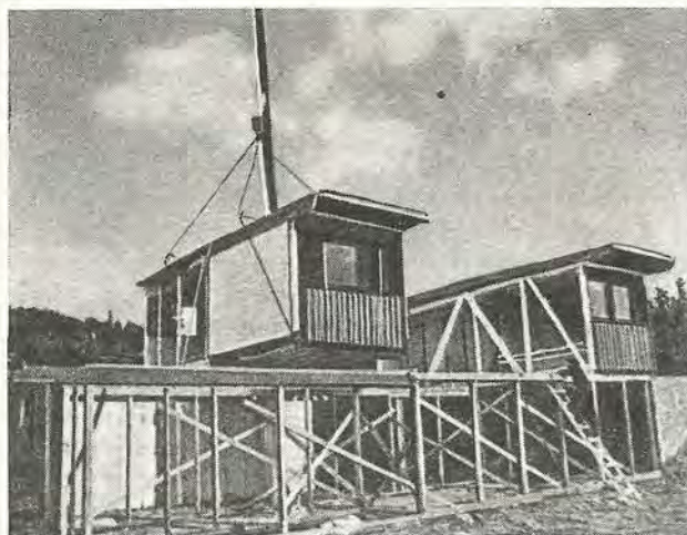
4. ábra. A térelem alapra helyezése daru segítségével
