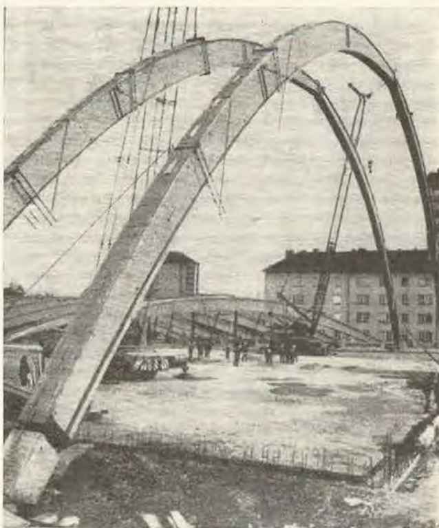
4. ábra. Hajlított rétegelt gerendák szerelés közben
