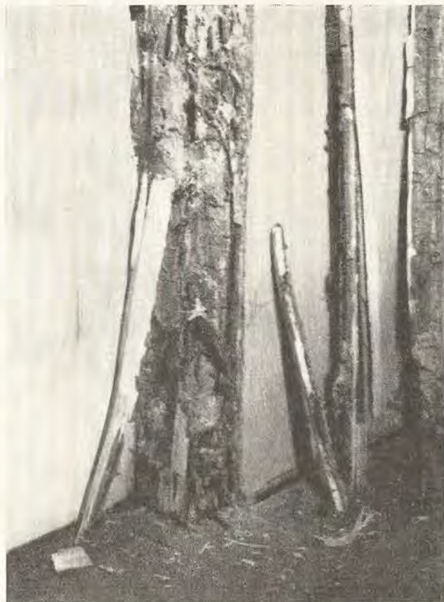
2. ábra. Ajtószerkezet széteső állapotban
