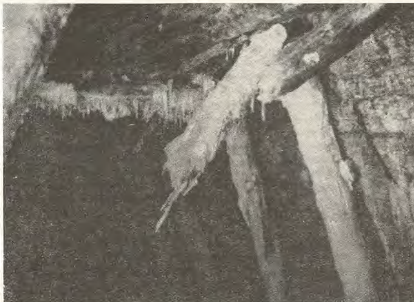
8. ábra. Poria vaporaria fertőzése bányavágatok faanyagában
