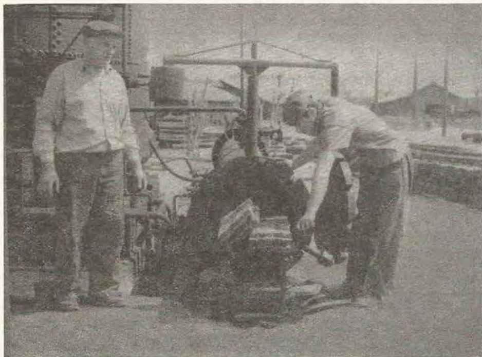
12. ábra. Zárt hengerben magas nyomás alatt történő védőkezelés
