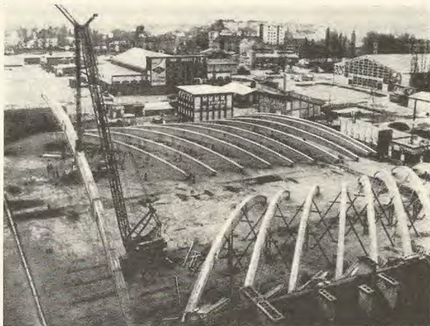
3. ábra. Szerelésre előkészített hajlított rétegelt gerendák
