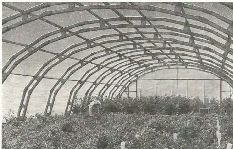
2. ábra. Rövid fűrészáruból készített ragasztott szerkezet (hajtatóház)
