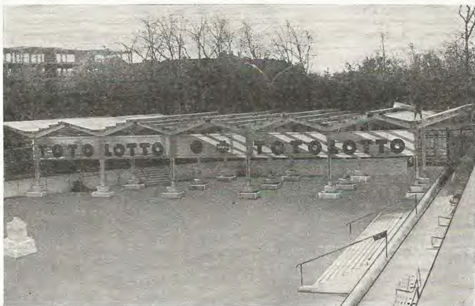
1. ábra. Akácfelhasználás Harkányfürdőben, erősen korrozív környezetben
