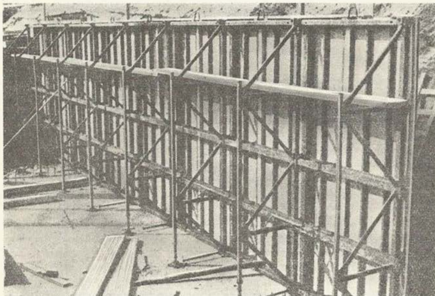
5. ábra. Nagy felületű zsaluzat különleges szerkesztésű tartószerkezettel
