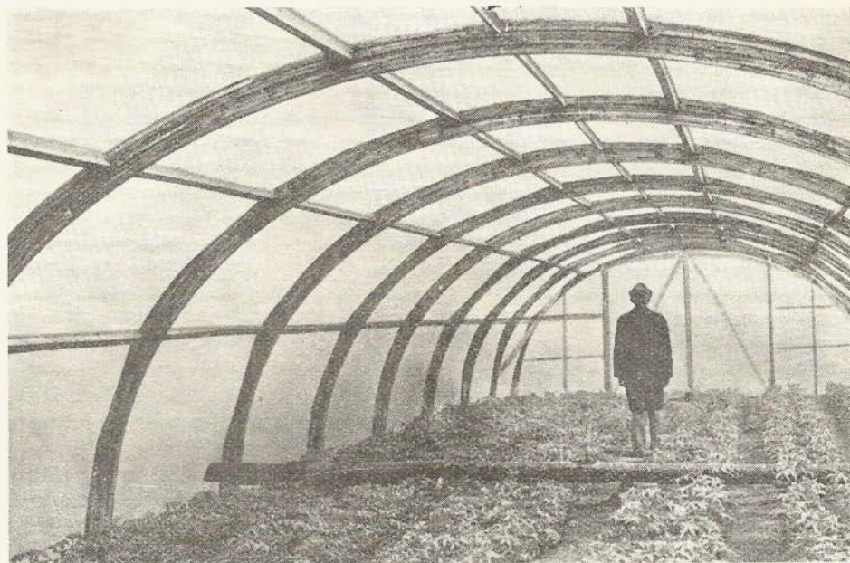
1. ábra. 6,4 m fesztávú fólia borítású növényház rétegelt-ragasztott, íves főtartókkal
