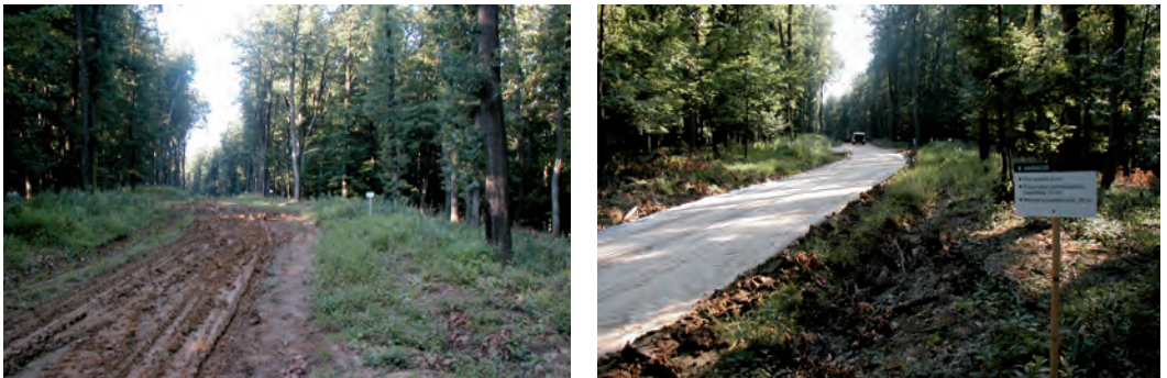
4. ábra: A földmű a mésszstabilizáció előtt és után. Figure 4: The earthwork before and after lime stabilization.
