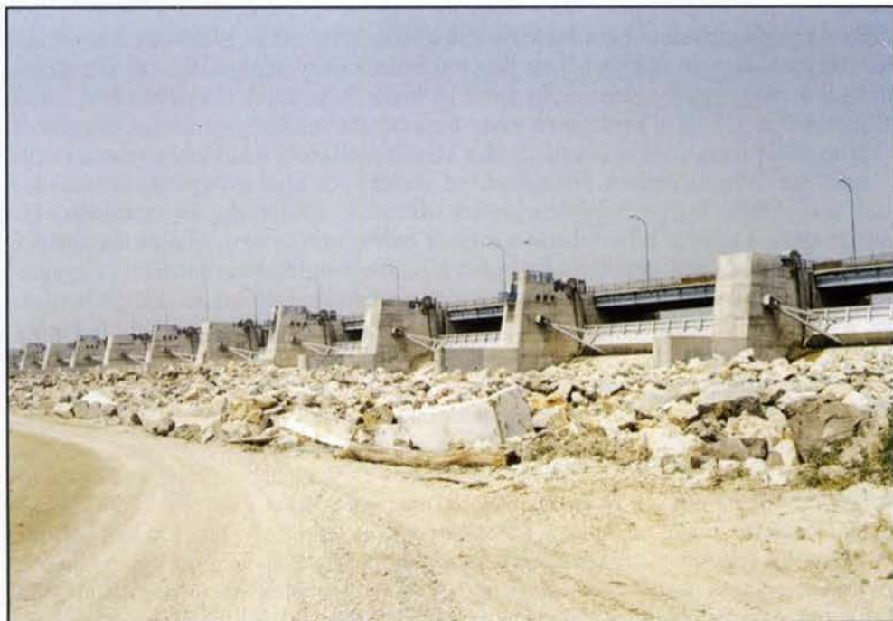
I. kép Épülő „C-variáns”, dunacsúnyi zsiliprendszer Pic. 1. Version „C” in construction, Dunacsúny dike locks
