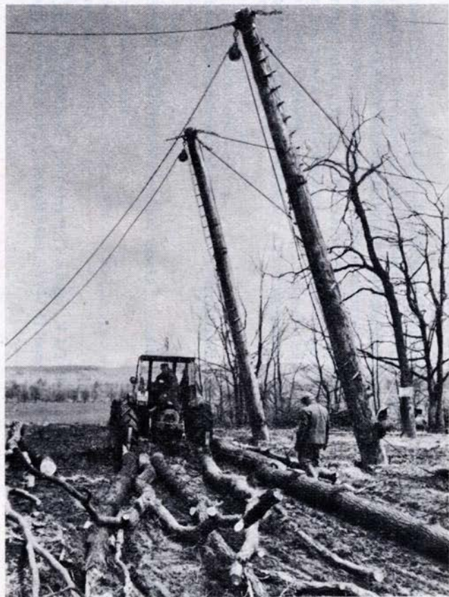
5. ábra. A D4-K félvonszolóval az árbocharu alá közelíti a szálfákat
