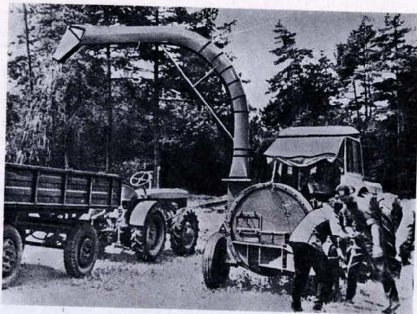
7. ábra. 1—9. számú minták aprítása (Karhula 312-B) (Fotó: ERTI, Maurer)
