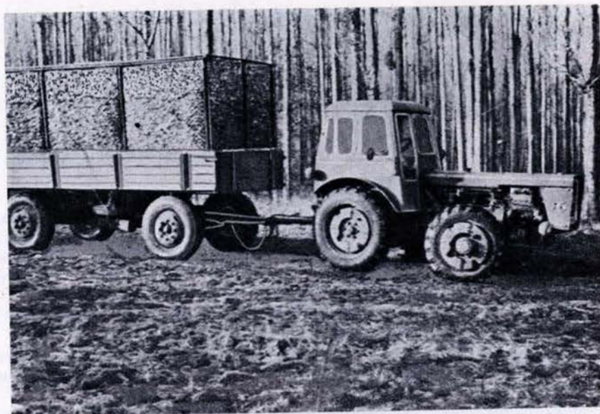
11. ábra. Apríték szállítás traktoros pótkocsival a Kölked 87/d erdőrezsletből a Mohácsi Farostlemezgyárba (Fotó: dr. Balogh)
