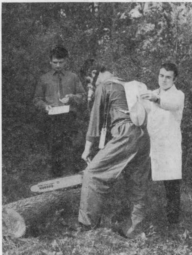
1. ábra. A munka közben kilehelt levegő mennyiségének mérésére szolgáló berendezés (Fotó: Michalovszky)
